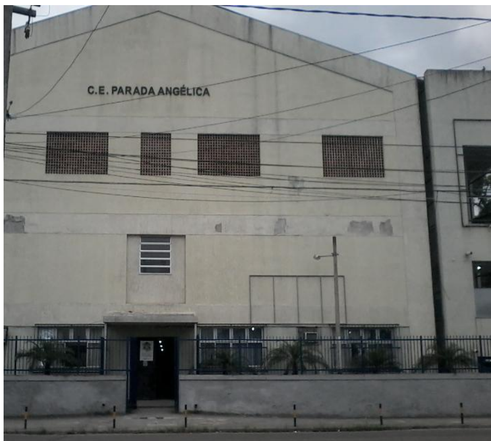
Figura 3 – Prédio atual do Colégio Estadual Parada Angélica.
