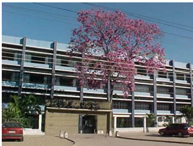
Figura 20: Fachada do Colégio de Aplicação Emmanuel Leontisinis
