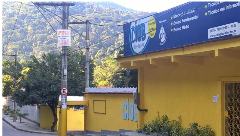
Figura 24 – O CIOB com a Rebio ao fundo e, no poste, uma placa de venda de lotes.
