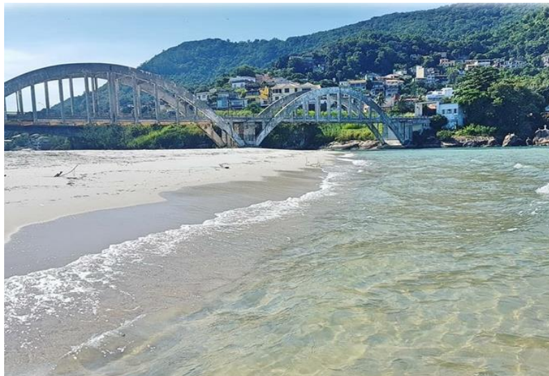
Foto 31 – Ponte da Restinga da Marambaia, Barra de Guaratiba
